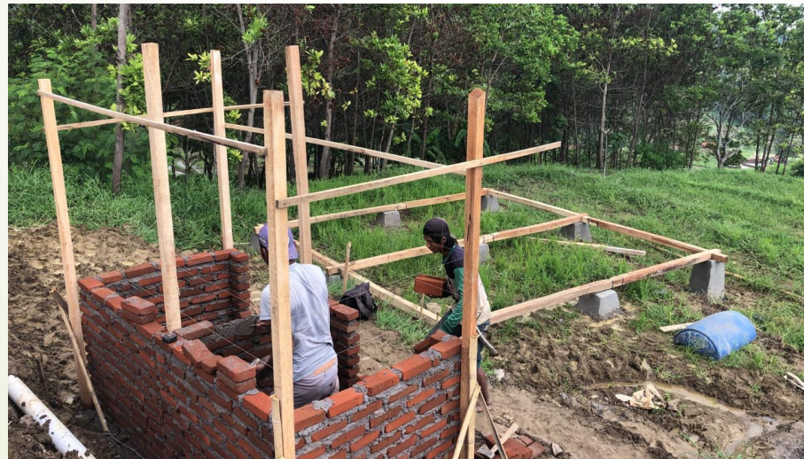
Pembangunan Mushala Al-Wardah
