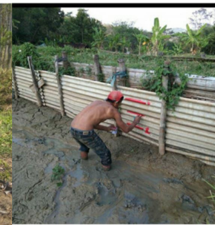
Pembuatan tanda garis muka air, mempermudah kontrol jumlah air di balong (28/8)
